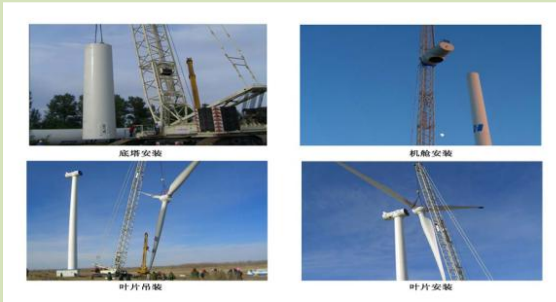
图 5 风机组安装示意图
