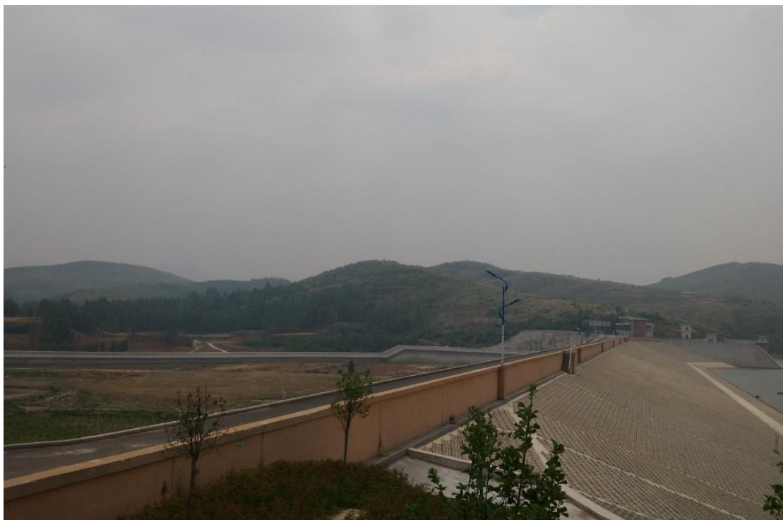
图 3.2-6 孤石滩水库南岸典型地貌
