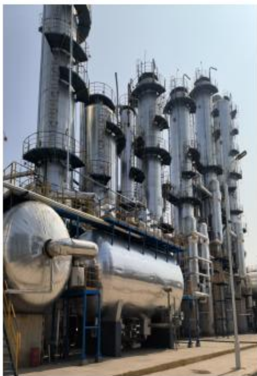
东厂区低压框架生产区
