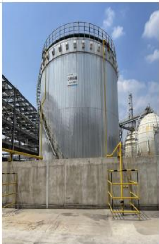
西厂区己内酰胺成品罐 2#
