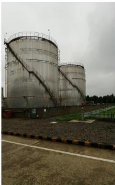
西厂区储运车间 3#罐区
