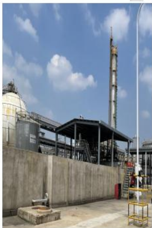
西厂区己内酰胺成品罐区 1#
