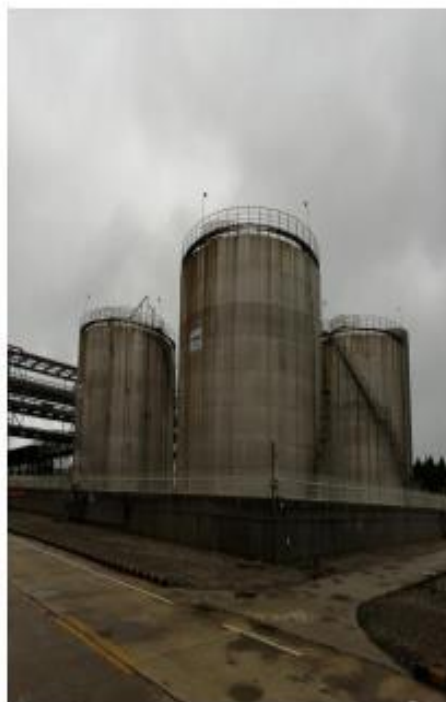
西厂区储运车间 2#罐区
