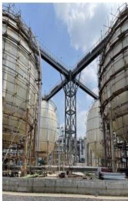
西厂区储运车间液氨罐区
