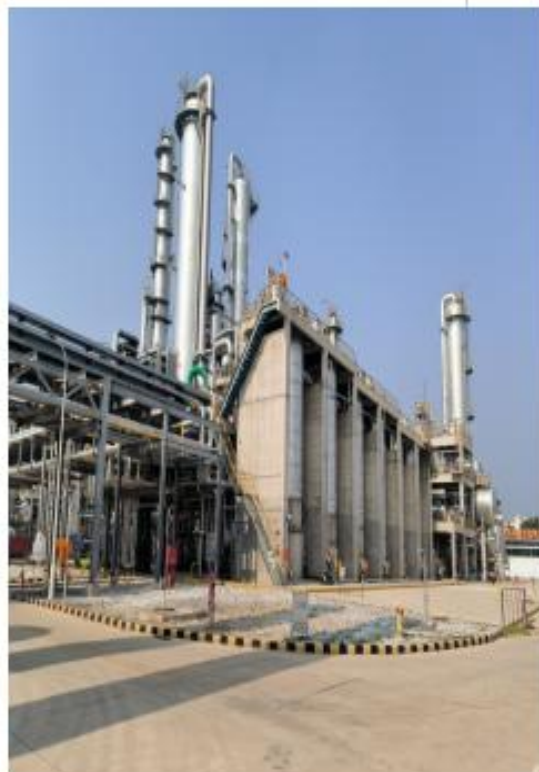
东厂区高压框架生产区
