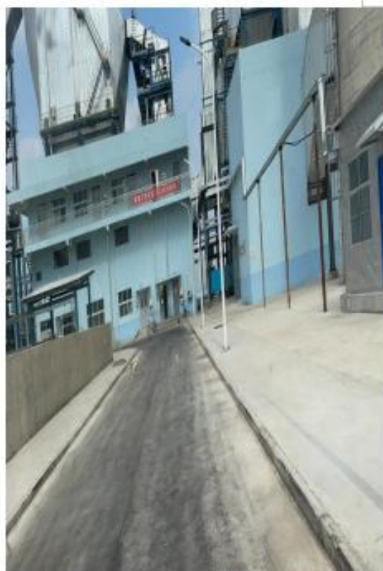
西厂区热电车间
