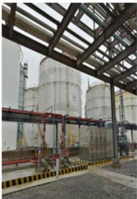
西厂区储运车间 1#罐区
