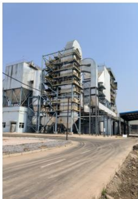
东厂区焚烧装置区
