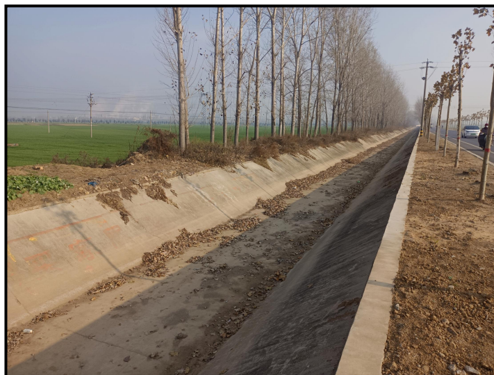
图 3-1 穿越白龟山水库南干渠现状图
