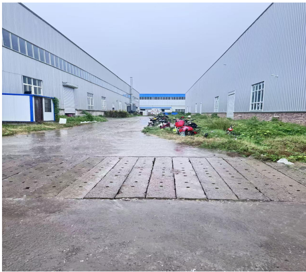
项目北侧造粒车间
