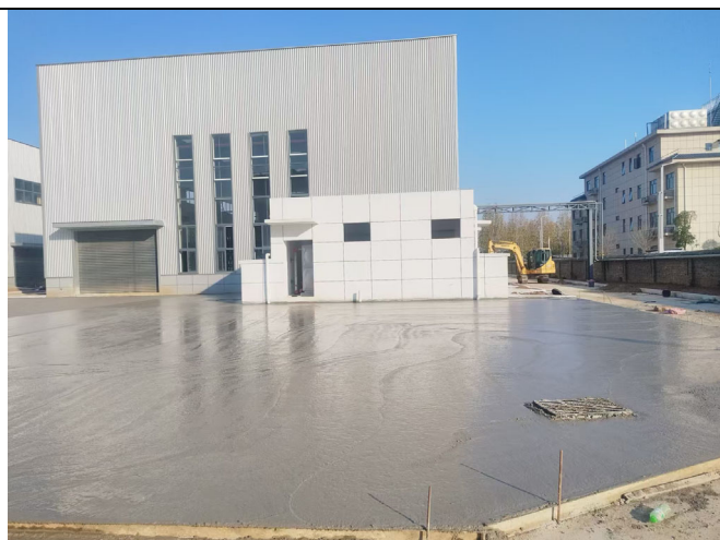
锅炉房位置现状及东侧水泵房
