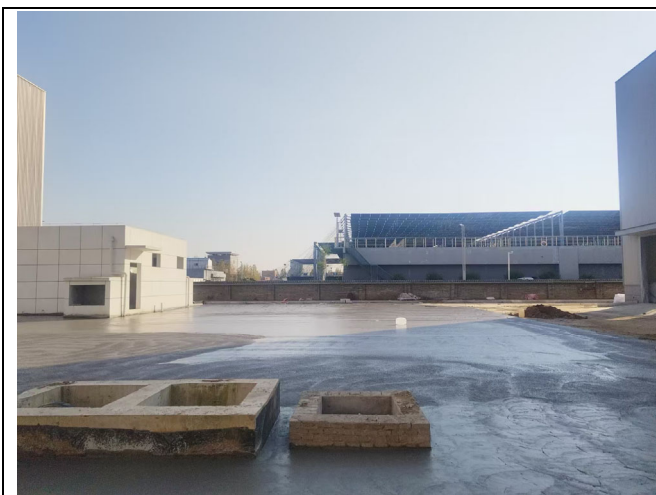
锅炉房位置现状
