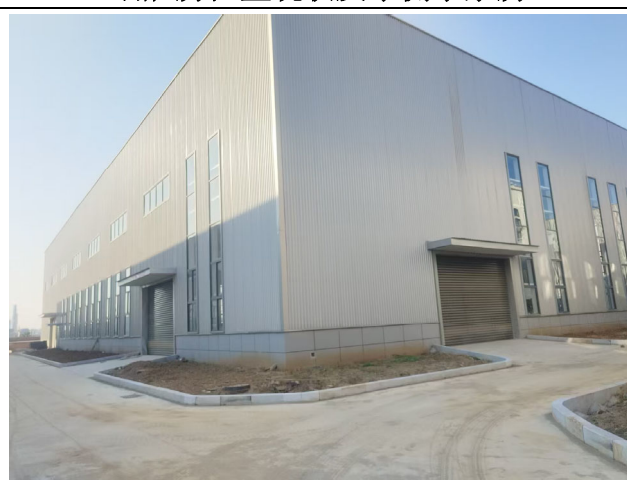
项目区西侧厂房
