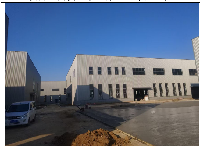
项目区北侧厂房
