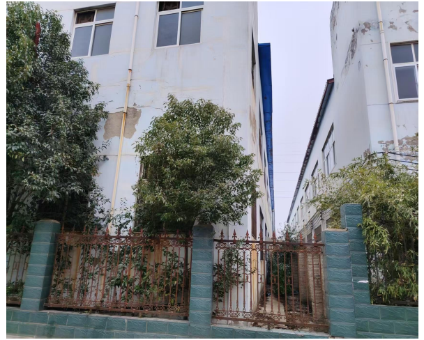
项目南侧闲置厂房
