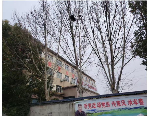
项目北侧平漯周高铁项目部
