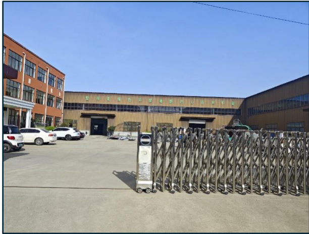
项目租赁厂区大门
