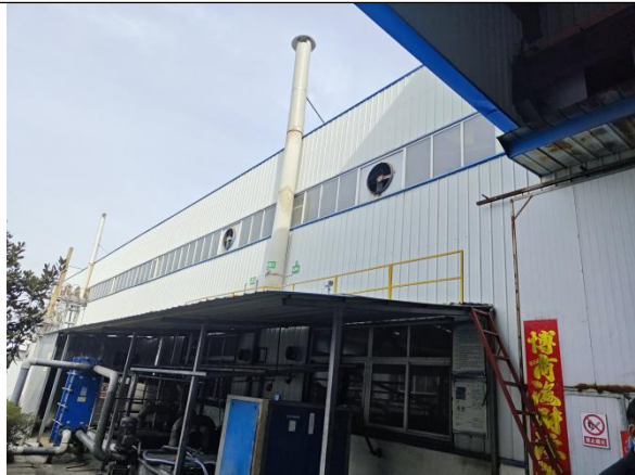
冷轧、精轧废气净化系统排气筒
