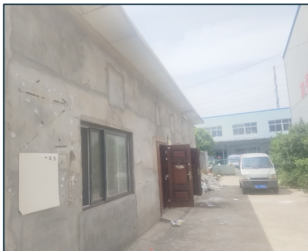
项目租赁厂区现状
