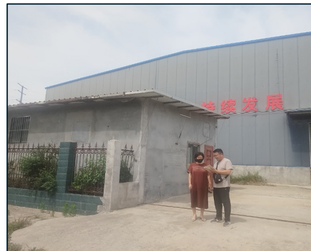
勘察现场照片
