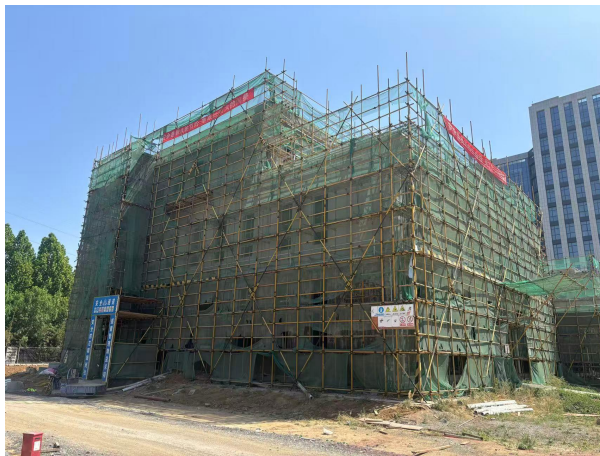
研发调度中心施工现状
