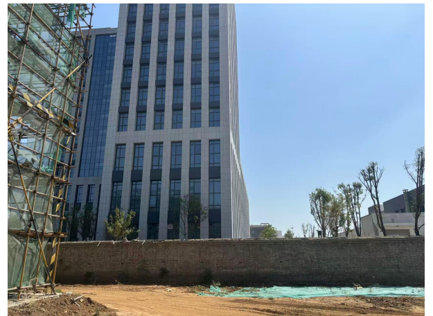
研发调度中心施工现状
