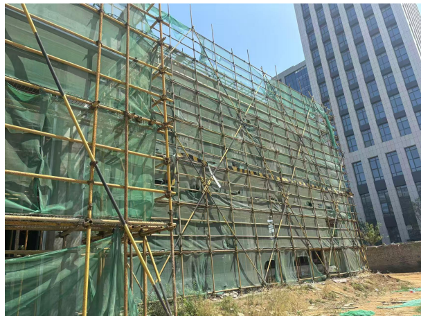
研发调度中心施工现状
