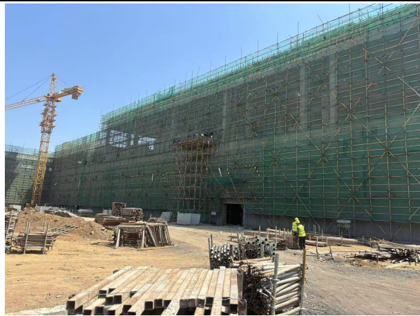
纺丝车间施工现状
