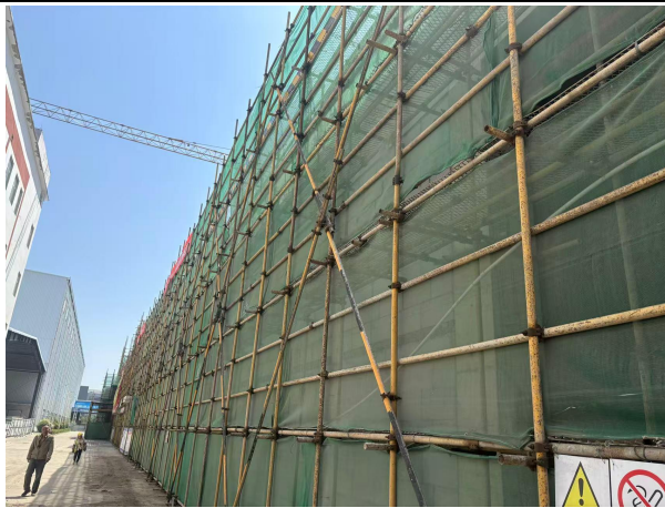
纺丝车间施工现状
