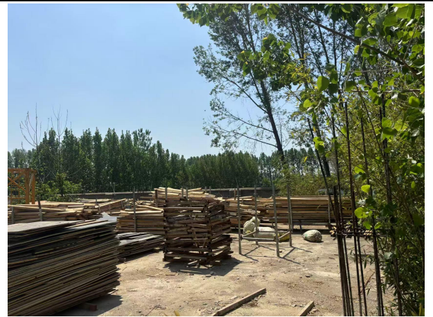
纺丝车间施工现状
