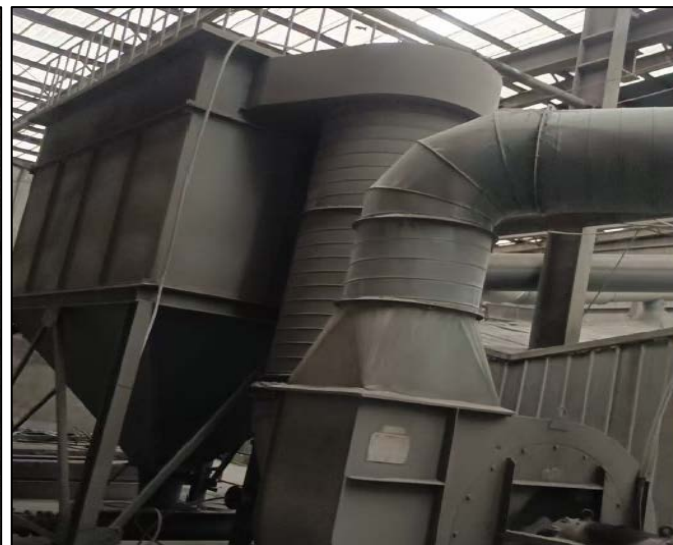
破碎、筛分袋式除尘器
