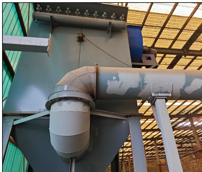
窑车清理袋式除尘器
