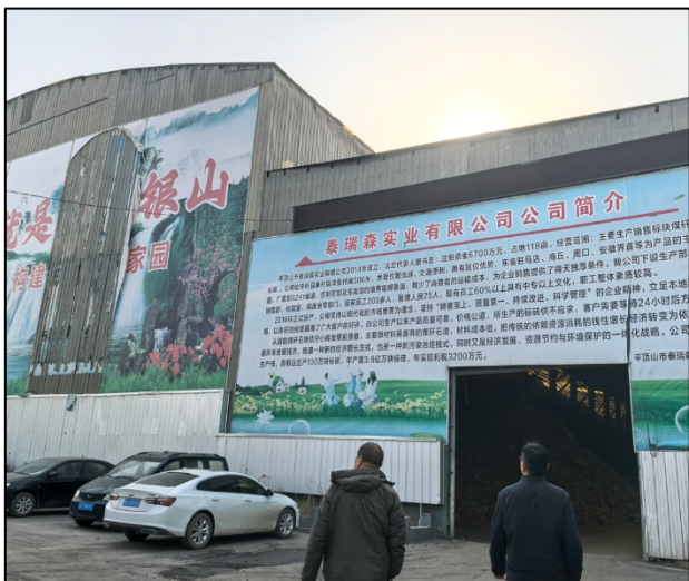
现有工程车间现状
