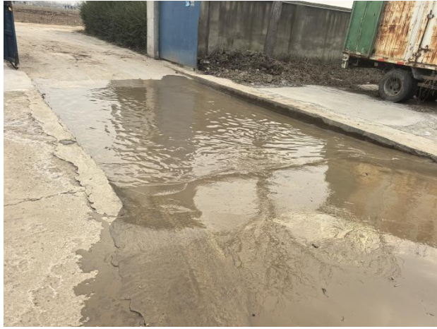
生产区进口处洗车装置
