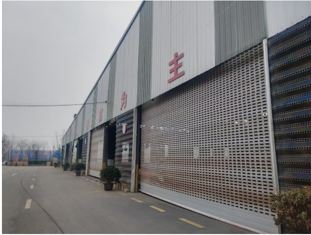
现有工程车间现状
