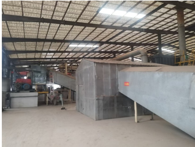
二次封闭及封闭输送廊道
