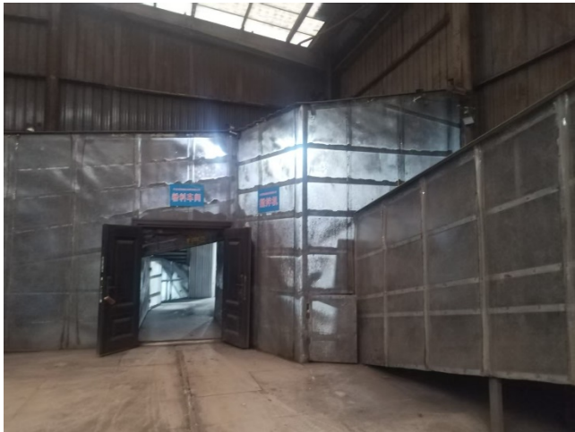
封闭输送廊道
