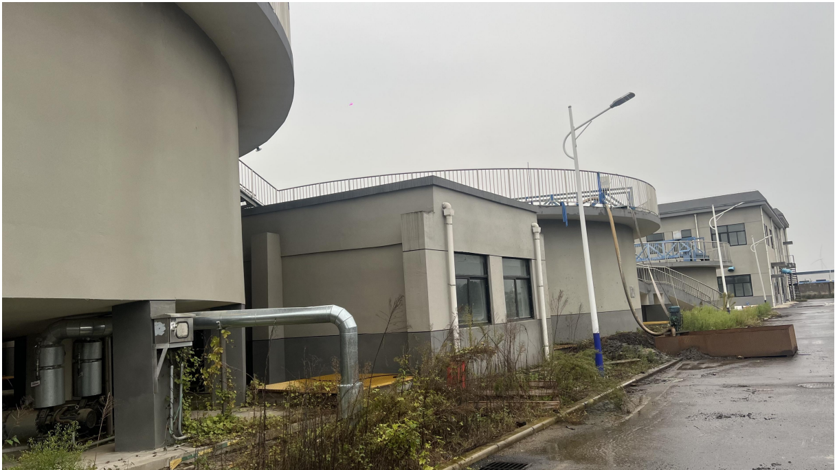
项目现有工程依托的污水处理站
